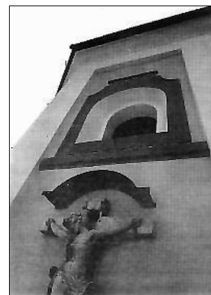
Obr. 29. Český Krumlov, poutní areál na Křížové hoře, detail rekonstruované barokní fasády centrální kaple.
