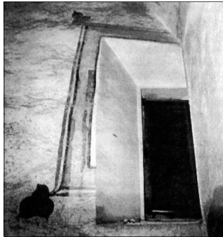
Obr. 2. Tábor, vícebarevná malovaná pasparta na odkrytém zbytku původního povrchu zadní fasády. pozdně gotické radnice.
