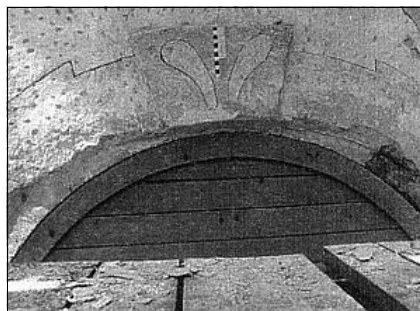
Obr. 30. Karlov - zámek, detail odkryté barokní barevné úpravy.
