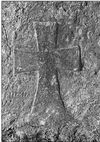
Obr. 1. Zahájí, detail omítkového křížku pasparty okna na jižním průčelí lodi, druhotně překrytého červeným celoplošným nátěrem.
