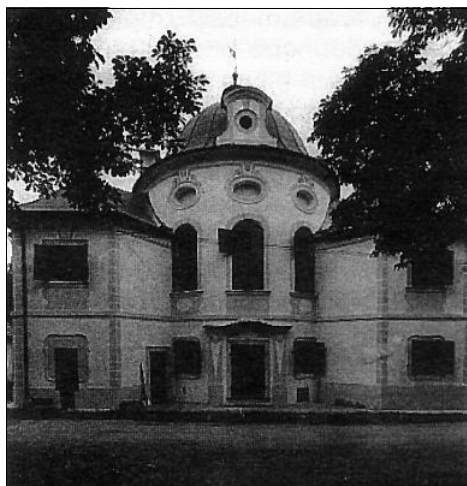
Obr. 28. Karlov - zámek, celkový pohled po obnově barokní barevnosti.
